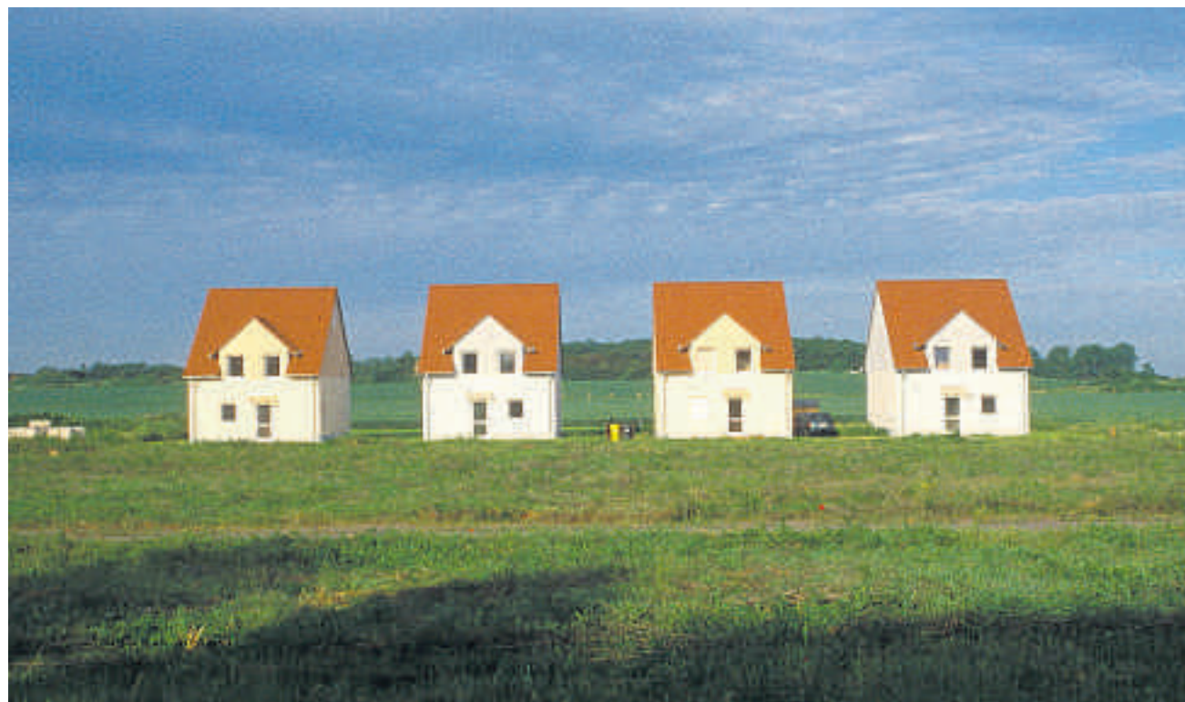
Standardisierung kann die Baukosten verringern. Die Materialwahl hat hingegen wenig Einfluss auf den Preis. SVEN DÖRING / VISUM
